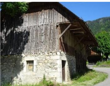
Hangar en bois bauju typique avec soubassement en pierres et grande avancée de toit - La Chapelle Saint Maurice. Photo PLUi RGLA
