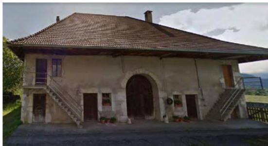
Ferme avec une parfaite symétrie des ouvertures, des escaliers latéraux sous toiture. La porte de grange centrée dans la façade avec encadrement en arc en plein cintre en pierre de taille - Villaz
